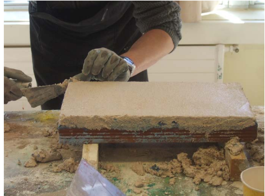
Y rematamos los bordes, ahora tenemos que dejar que el mortero se “oree”, dejándolo secar hasta que las superficie no moje al tacto.
